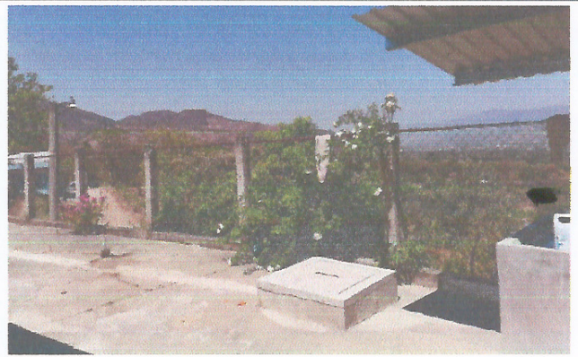
Foto 2: Reparación de cerco o muro perimetral
