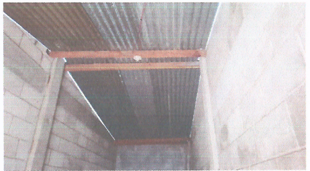
Foto 4: Mejoramiento de entechado de bodega
