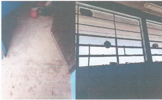
Foto 1: Cambio de piso y ventanas
