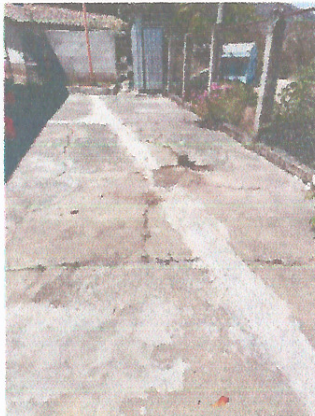
Foto 3: Reparación de Losa de patio
